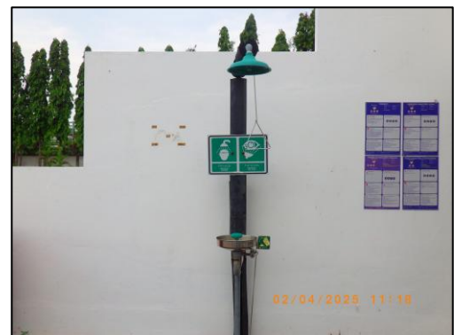
รูปที่ 3.87 ฝักบัวและอ่างล้างตาฉุกเฉิน
