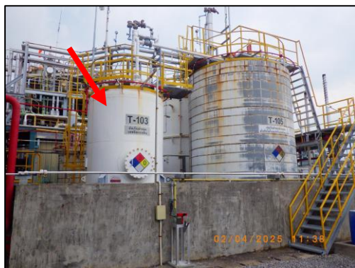
รูปที่ 3.15 ถังเก็บสำรองเอทิลเบนซีน
