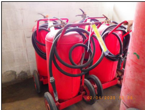
รูปที่ 3.68 ตู้ดับเพลิง ชนิดผงเคมีแห้งแบบล้อเข็น บริเวณอาคาร Fire Pump
