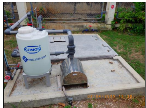
รูปที่ 3.20 ปั๊มพักน้ำ บริเวณจุดระบายน้ำทิ้งจาก Office & Canteen
