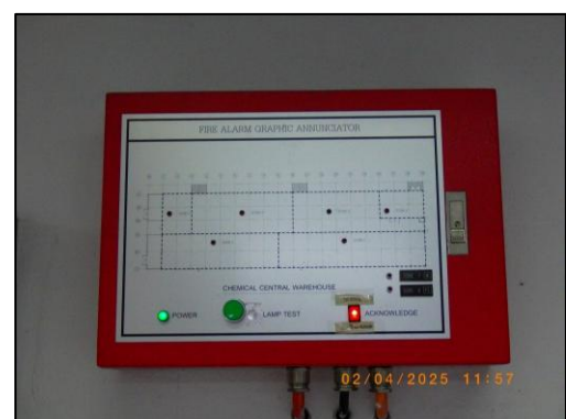
รูปที่ 3.83 แผงไฟของระบบส่งสัญญาณเตือน จาก Gas Detector
