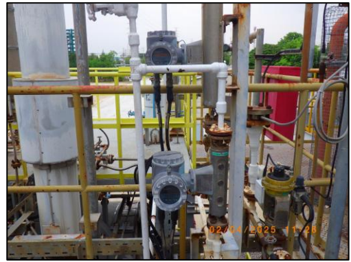
รูปที่ 3.105 Temperature Indicator และ Pressure Indicator
