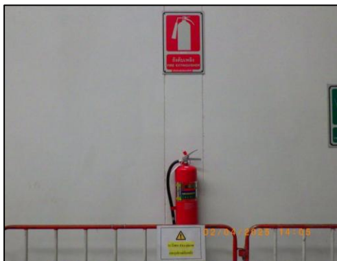
รูปที่ 3.107 ถังดับเพลิงชนิดผงเคมีแห้ง บริเวณอาคารเก็บสารเคมี
