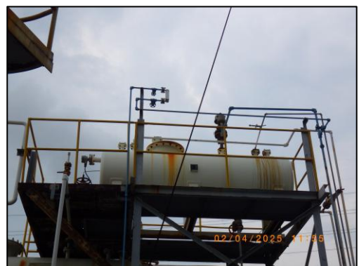
รูปที่ 3.12 ถังเก็บ Recovered Volatile (RV) ที่ผลิตจากกระบวนการผลิต
