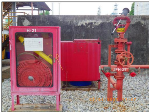
รูปที่ 3.76 Jet Foam Hydrant (JF) บริเวณพื้นที่กระบวนการผลิต
