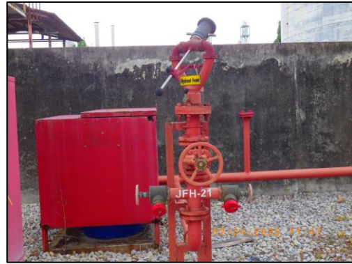
รูปที่ 3.75 Jet Foam Hydrant & Hose (JFH) บริเวณพื้นที่กระบวนการผลิต
