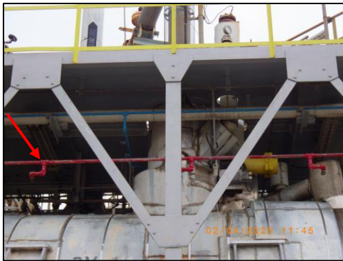
รูปที่ 3.79 Springkler Water Spray บริเวณกระบวนการผลิตเม็ดพลาสติกโพลีไทรีน (ต่อ)
