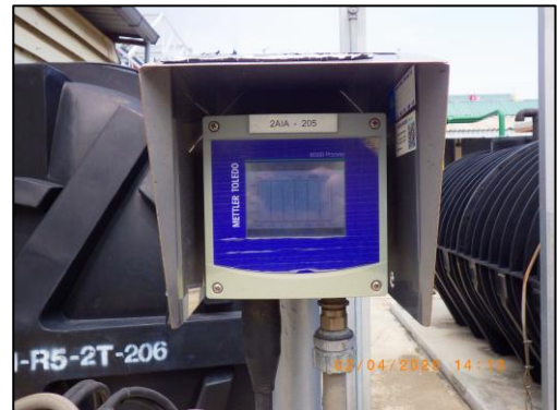
รูปที่ 3.114 pH Online บริเวณถังพักน้ำ ขนาด 8 ลูกบาศก์เมตร
