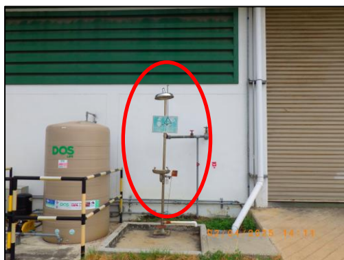
รูปที่ 3.109 ฝักบัวล้างตาฉุกเฉิน บริเวณอาคารเก็บสารเคมี
