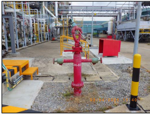
รูปที่ 3.74 Jet Hydrant & Hose (JH) บริเวณพื้นที่กระบวนการผลิต
