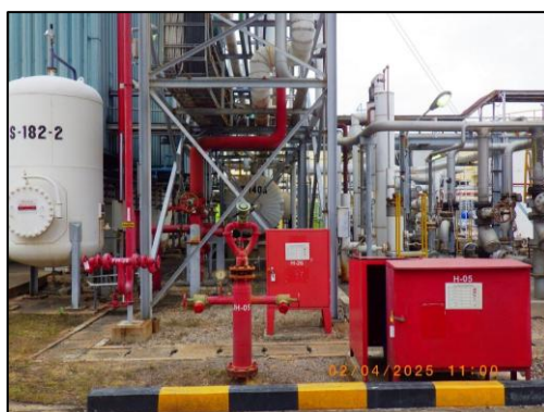
รูปที่ 3.72 Hose & Hydrant Cabinet (H) บริเวณพื้นที่กระบวนการผลิต
