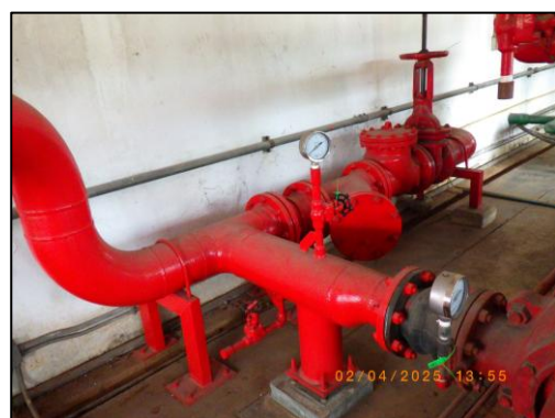
รูปที่ 3.63 เครื่องสูบน้ำดับเพลิง (Firewater Pump) บริษัทมหาชน Fire Pump
