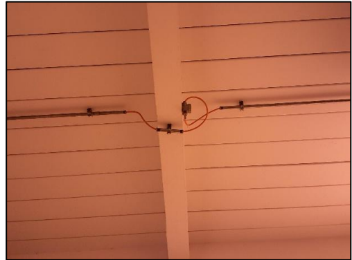
รูปที่ 3.85 Heat Detector บริเวณอาคารเก็บสารเคมี
