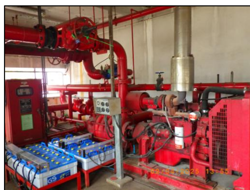
รูปที่ 3.63 เครื่องสูบน้ำดับเพลิง (Firewater Pump) บริษัทมหาชน Fire Pump
