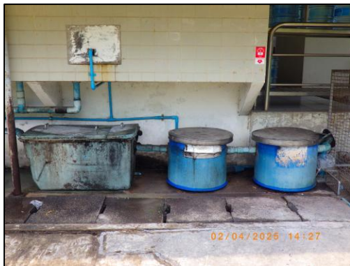
รูปที่ 3.19 Grease Trap (ถังดักไขมันจากโรงอาหาร)
